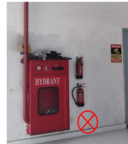
Tidak ada rambu-rambu pada APAR dan HIDRAN
